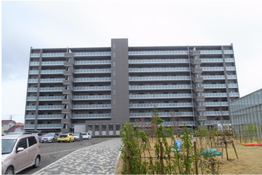
総合病院国保旭中央病院医師宿舎
