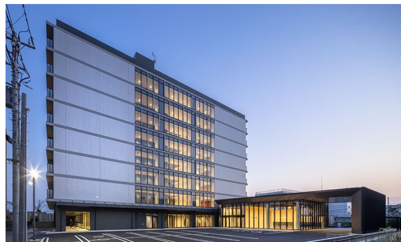
総合病院国保旭中央病院看護師宿舎
