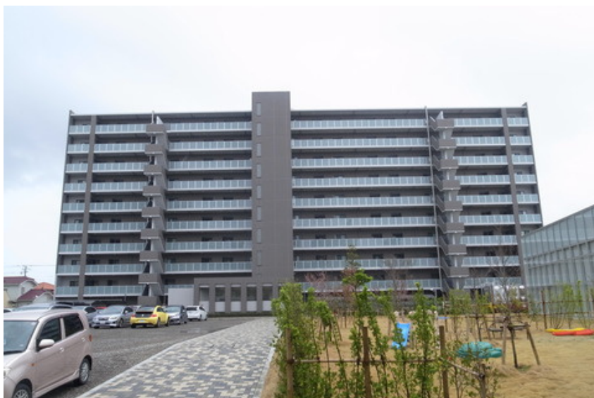
総合病院国保旭中央病院医師宿舎
